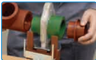
Fusione el niple entre-fusión al accesorio.
